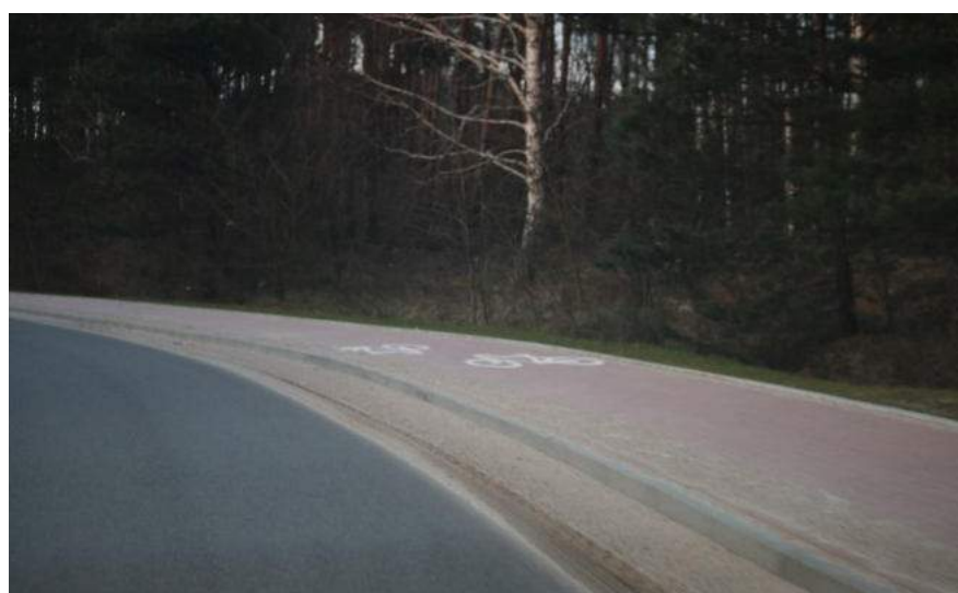
Fot. 11.1. Droga rowerowa o funkcji komunikacyjnej, wzdłuż ulicy Rzemieślniczej, między Kosakowem i Mostami
