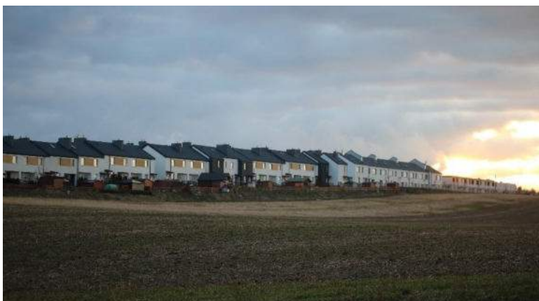
Fot. 5.1. Zabudowa mieszkaniowa w formie zabudowy szeregowej w Dębogórze
