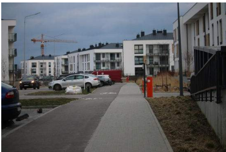
Fot. 5.3. Zabudowa mieszkaniowa wielorodzinna w Pogórze
